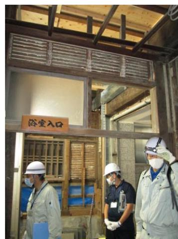
完成すると一般客には見られない床下の配管、ポンプなどは今回の工事でメンテナンスのし易いスッキリとした状態にするようで、地下を掘り下げコンクリートの地下壕のような機械室を作り、その中に収めるようです。これらの設備、配管等は新しい物に変えていくそうですが、昨年 9 月に見つかった陶製の排水管(直径 30cm、長さ 50cm の管で総延長約 20m)は明治 27 年当時の敷設と見られ、本館の維持に一定の役割を果たしているとして、市は当初予定していた撤去を見送ることにし、今後も湯以外の排出の役割を担わせることにしたそうです。天井の梁や壁面の補強に金属製の部品や筋交いダンパーのような物も使ってありましたが内装を行うと全く分からなくなるそうです。(右図:配管類)
