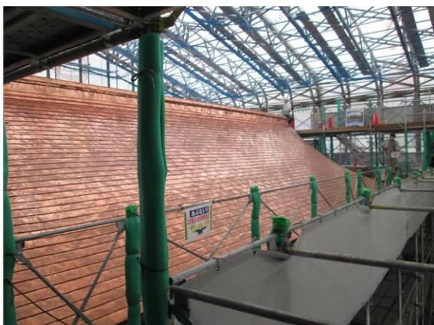
また、又新殿(ゆうしんでん)の屋根は明治 32 年完成当時は「ひわだぶき」だったそうですが昭和 44 年に銅板葺きに変更されていたのだそうです。緑青がふいた緑色の屋根でしたが、本工事で、新しい銅板(32cm×12cm)約 3000 枚を葺き替え、黄金のように光り輝いていました。(左の写真)
